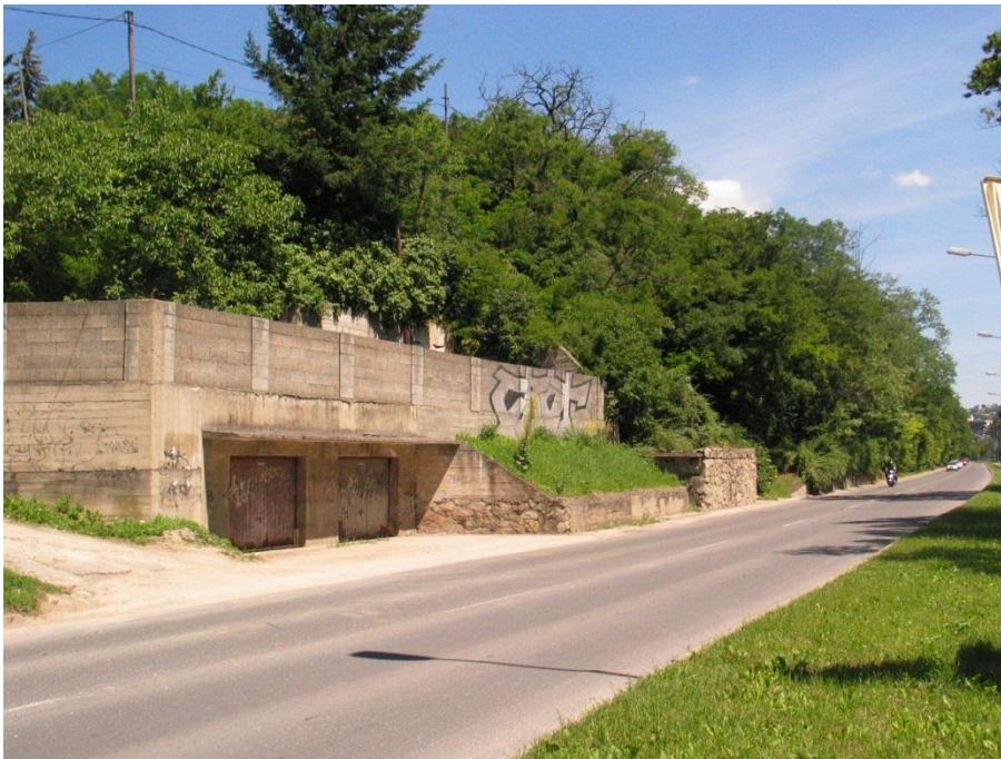
Oporná konštrukcia ako súčasť objektu
